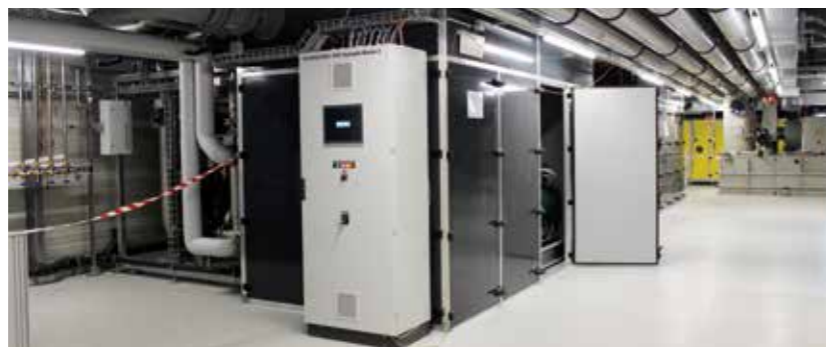
Ammoniakkältemaschine in Schutzhäusung
