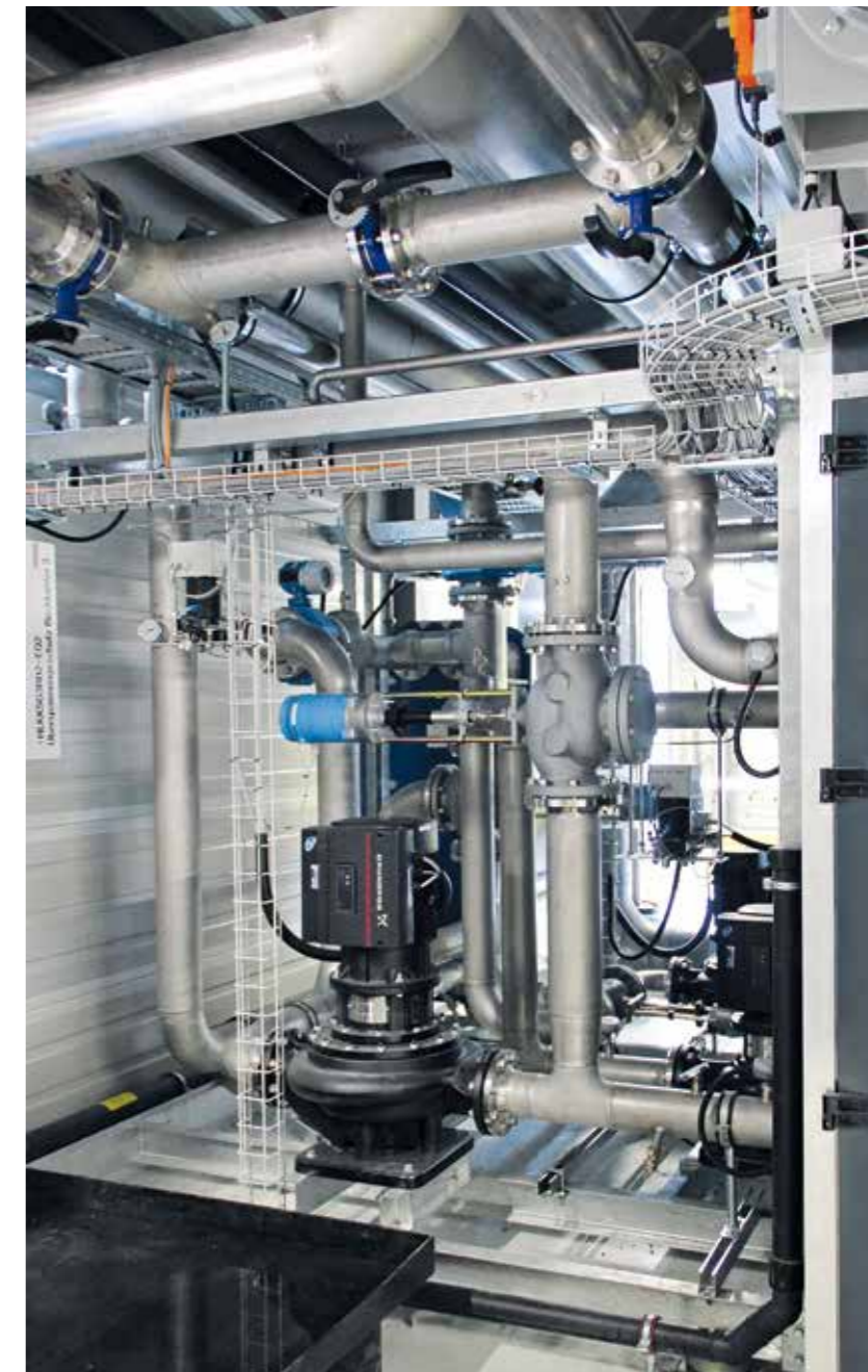
Hydraulikmodul mit Systemtrennung
